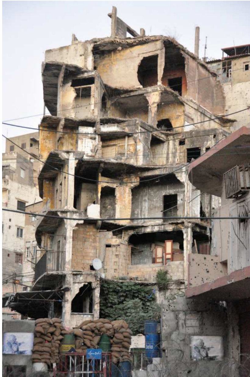
Trípoli, Líbano, edificación afectada por la guerra, septiembre de 2013
